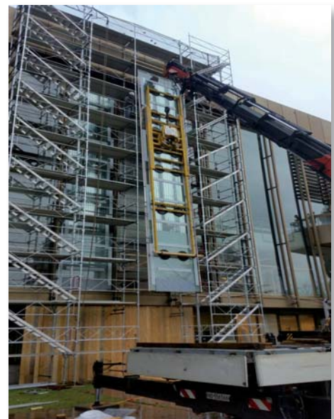
Dépose des verres existants feuilletés par des plaques d'acier collées
