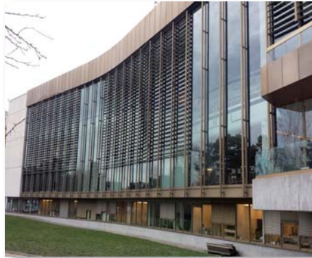
Façade vitrée du bâtiment E
