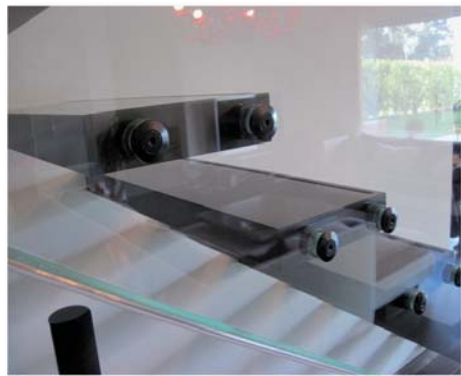
Détail de la fixation des marches
