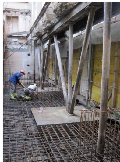
Etayage de la façade au rez
