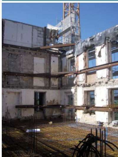
Reconstruction de la dalle sur niveau 3
