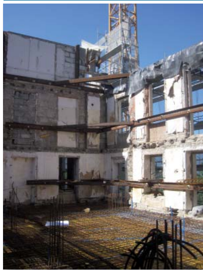
Reconstruction de la dalle sur niveau 3
