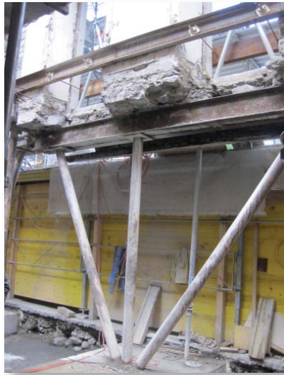
Etayage de la façade au rez
