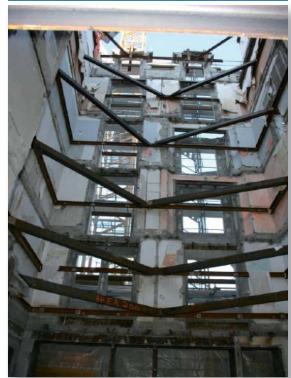
Etayage de la façade (n° 30), février 2012
