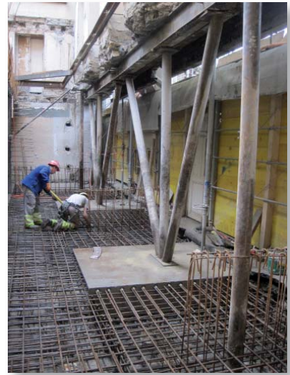
Etayage de la façade au rez
