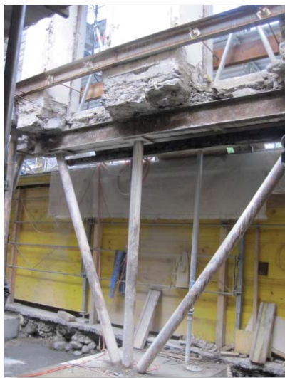
Etayage de la façade au rez
