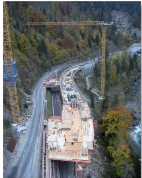
Vue d'ensemble de l'ouvrage en construction
