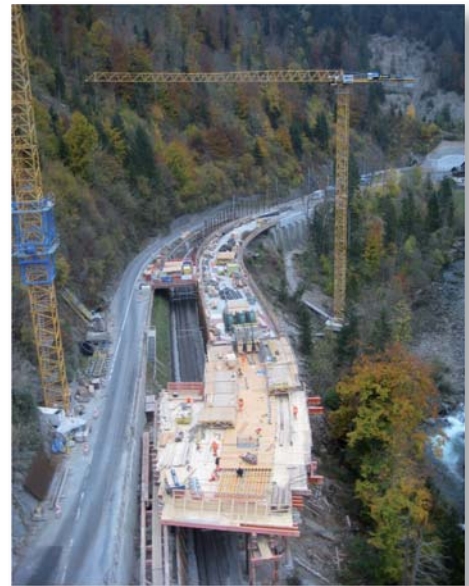
Vue d'ensemble de l'ouvrage en construction
