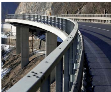
Vue du pont passant au-dessus de la ligne du MOB
