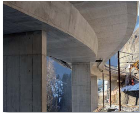
Vue du caisson du pont
