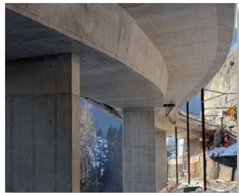
Vue du caisson du pont
