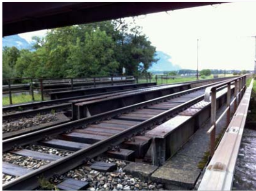
Vue du pont existant en structure métallique
