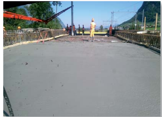
Bétonnage du tablier du nouveau pont
