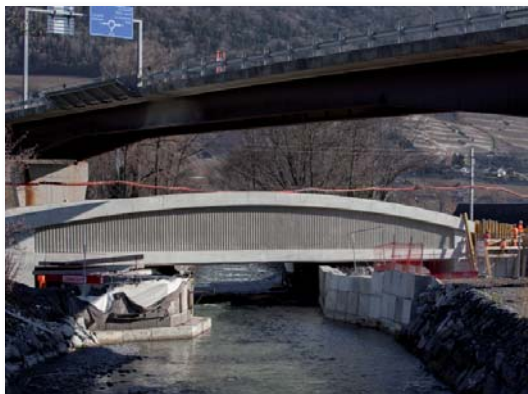
Nouveau pont ripé
