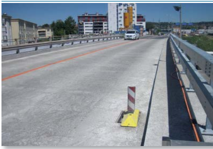
BFUP sur chaussée et sur trottoir
