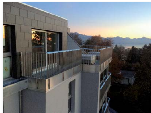
Toiture et façade
