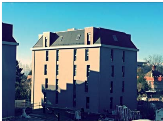
Façades Nord et Est terminées
