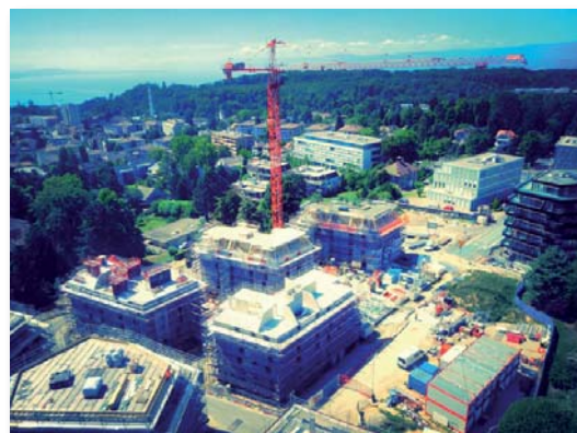
Vue aérienne du gros oeuvre en cours
