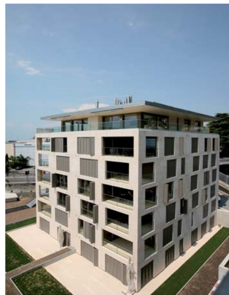
Façade Sud-Est bâtiment B
