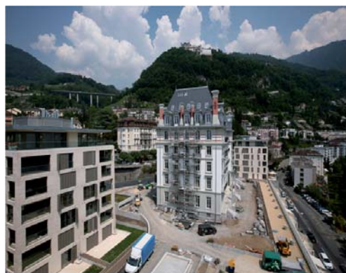
Vue du complexe depuis l'immeuble A
