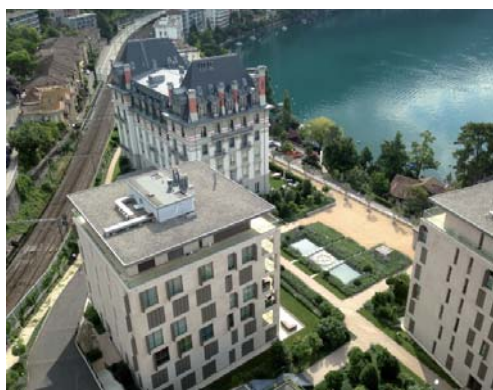
Vue d'ensemble avec les aménagements extérieurs et la ligne CFF
