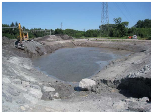
Creuse du bassin de rétention
