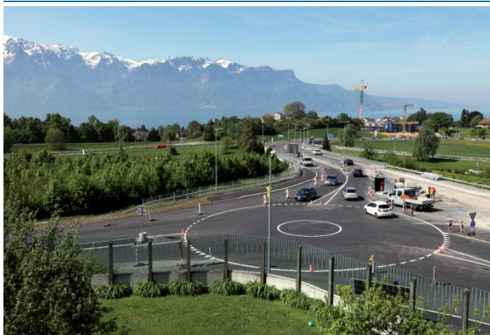
Travaux réalisés par phases avec maintien de la circulation
