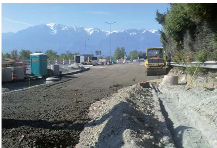
Pose de conduites d'éclairage et réalisation de la couche de fondation de chaussée
