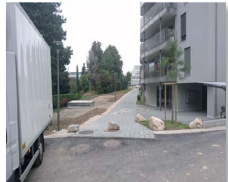
Chemin pavé avec tranchée d'infiltration
