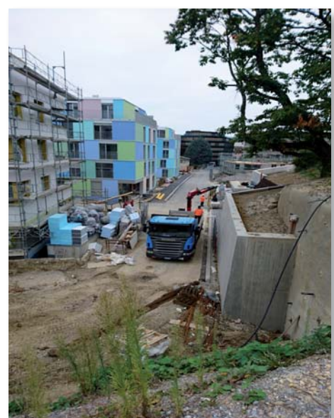
Réaménagement complet d'une route d'accès
