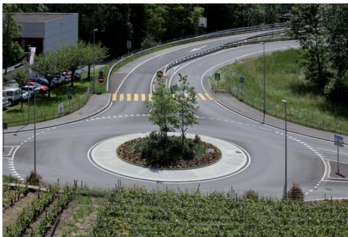
Giratoire Montagne - Situation après travaux
