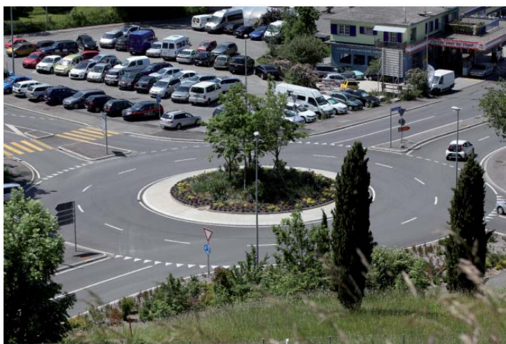
Giratoire Lac - Situation après travaux
