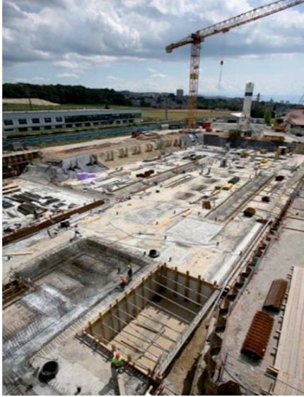
Vue d'ensemble - fondations sur pieux
