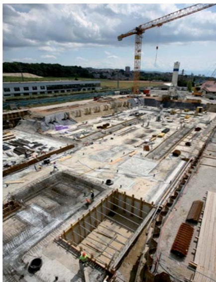
Vue d'ensemble - fondations sur pieux
