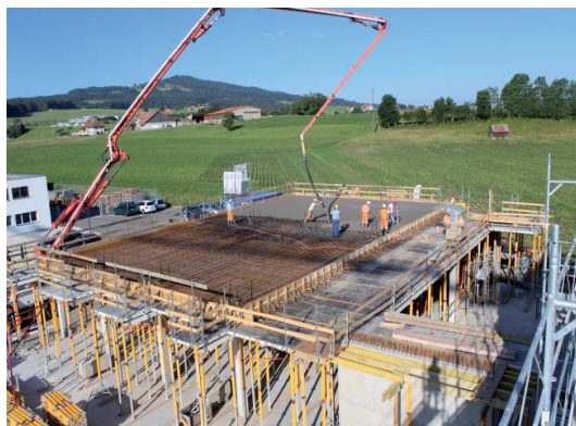
Bétonnage dalle précontrainte
