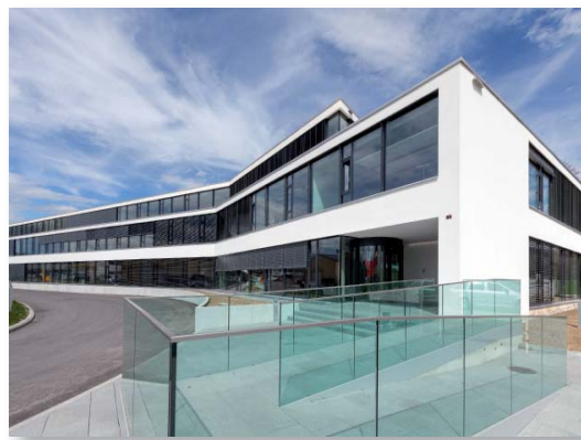
Vue de la façade côté Sud
