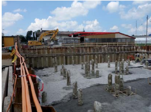
Travaux spéciaux pieux et palplanches
