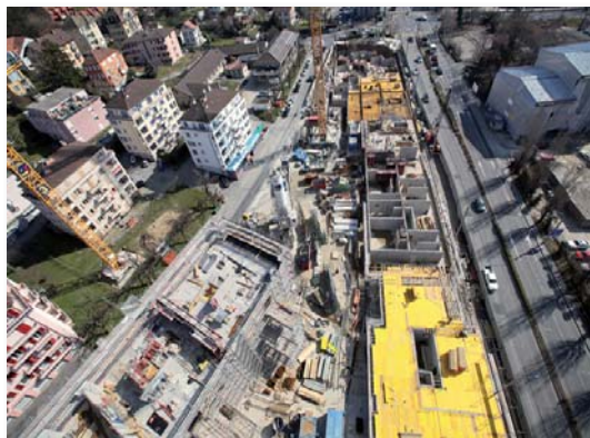
Projet en construction
