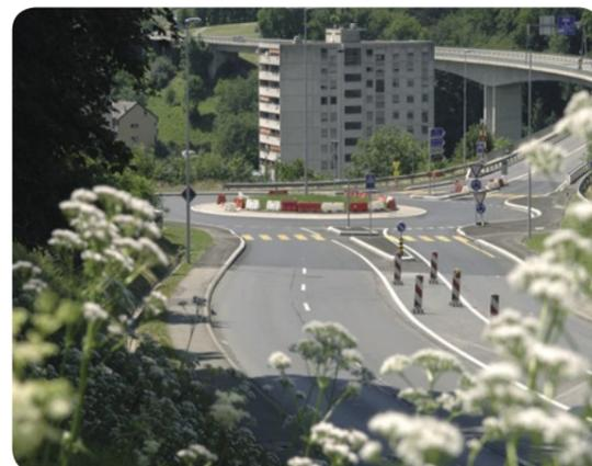
giratoire a un diamètre de trente mètres. Sa pastille centrale est cerclée d'une zone pavée semi franchissable. Toute la chaussée du secteur a été refaite à neuf et la signalisation entièrement renouvelée.
